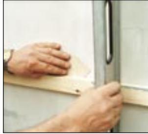
2 Uppriktning med hjälp av distansbitar bakom regel.
