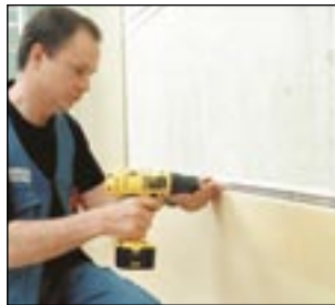
6 Fastskrivning av skarvprofil.
