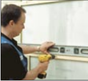
1 Uppsättning av reglar bakom paneler.
