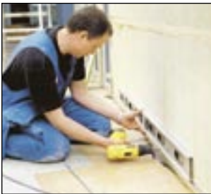
5 Fastsättning av nedre startprofil.
