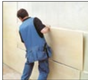
7 Montering av nästa panel.
