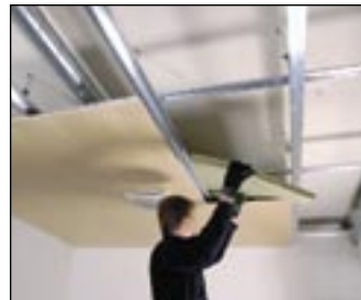
7 Iläggning av mineralullsisolering.
