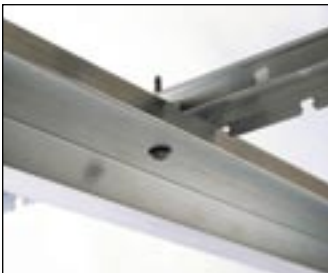
5 Säkring av snäplås med själv-gängande skruv.
